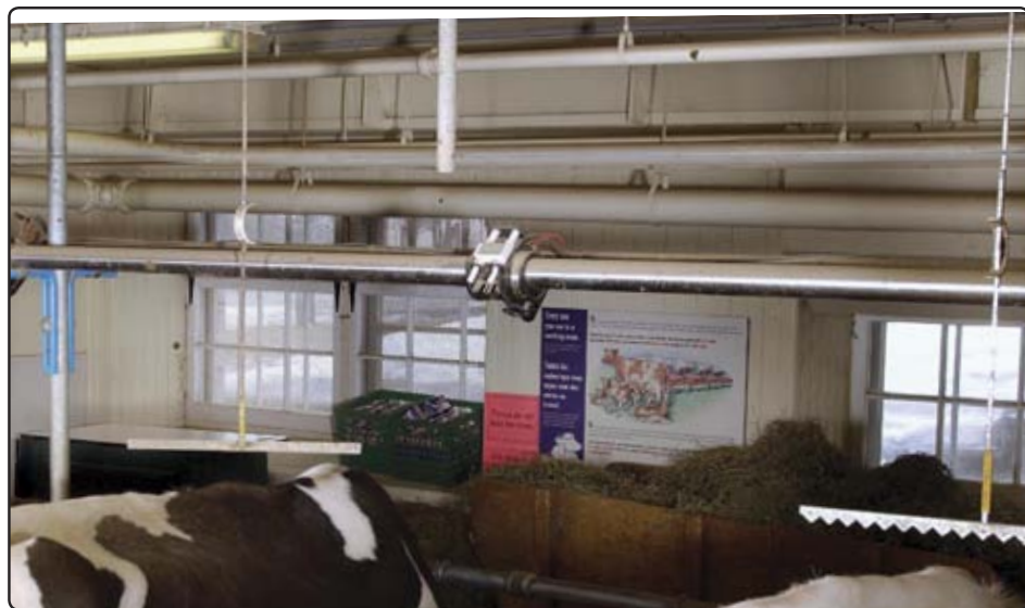
Dans un lactoduc moderne, chaque stalle est branchée à un réseau de canalisation à vide auquel le préposé connecte les tuyaux de la trayeuse.
